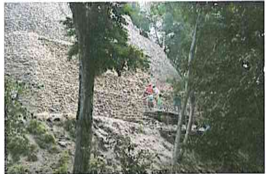
Edificio B-24, fachada sur.
