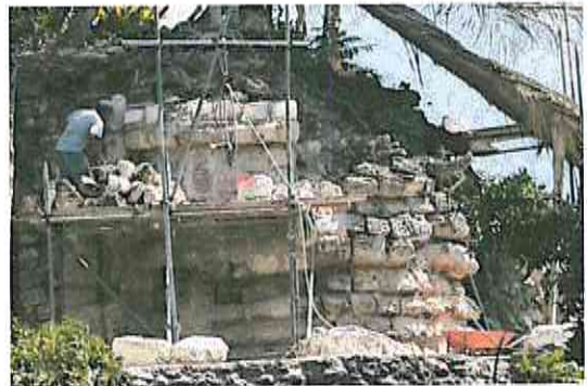
Trabajos de restauración en esquina noroeste extremo lado norte.
