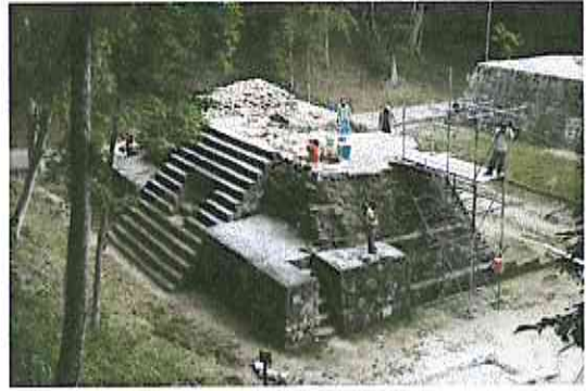
Edificio 395 visto desde la esquina suroeste
